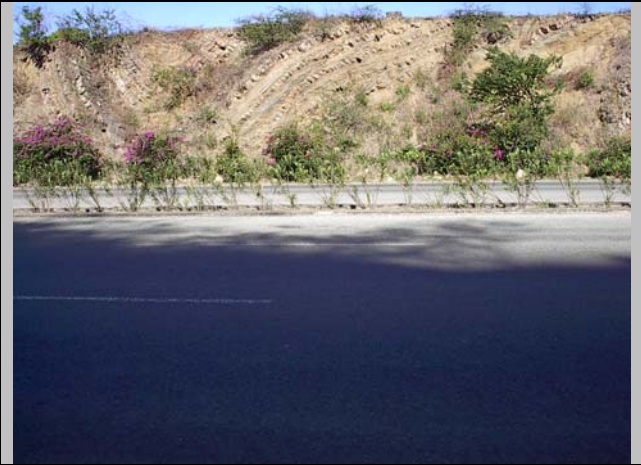
Tobas del Grupo El Cobre plegadas formando un sinclinal, con un comportamiento muy estable antes los taludes de fuertes pendientes.
