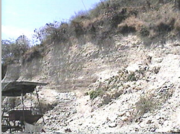
Loma del Kake, taludes verticales muy estables, en roca margosa y calcarenita.
