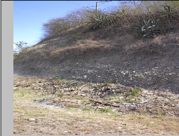
Fondo de la Polivalente, donde aparecen capas de conglomerados del Mbro Santiago, pendientes estables en los taludes.
