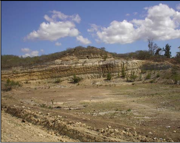
Secuencia de capas de margas y areniscas calcáreas muy estable en un talud de 90°, en la entrada del Rpto 30 de Noviembre yendo por la Circunvalación.
