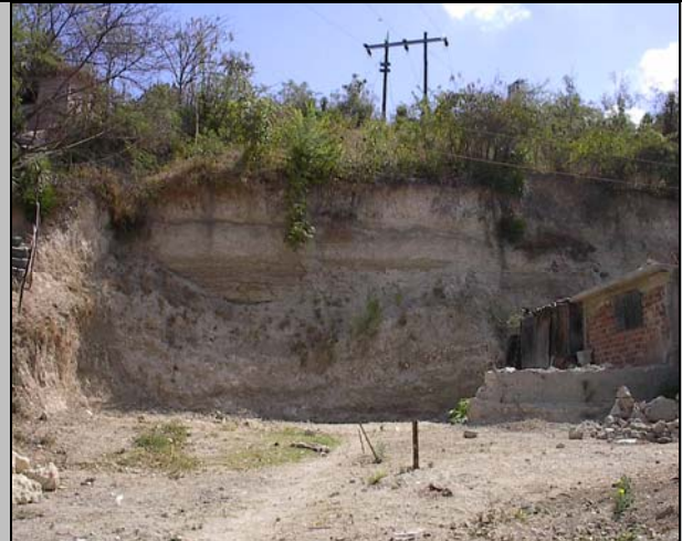
Casa construida al pie de un talud de marga de la Fm. La Cruz en el Rpto Antonio Maceo. Refiérase que solo en caso de fuertes lluvias hay desprendimiento de pedazos de rocas.
