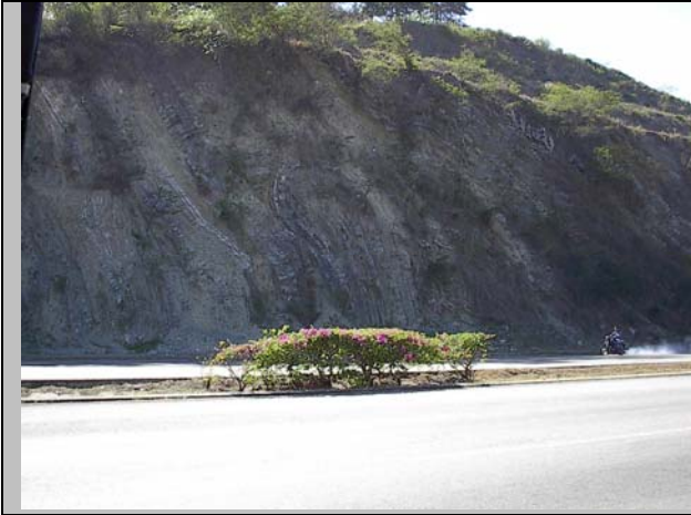
Talud en la Autopista, cortado en tobas con yacencia casi vertical, formando un talud muy estable a los deslizamientos.
